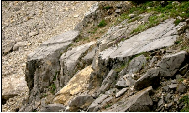
Fig. 4: Beispiel der ebenen großflächigen hangparallelen Trennflächen im Bereich des Felssturzes von 1976
